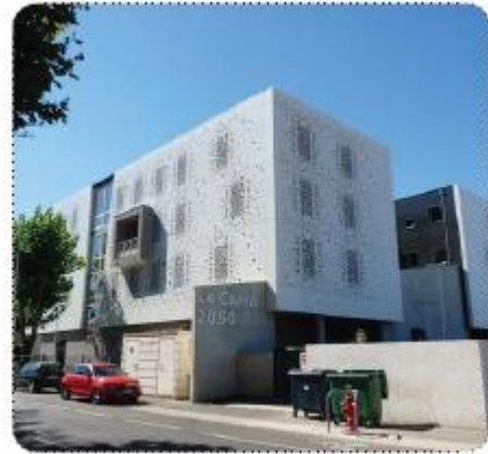
1 Parc tertiaire G. Besse II
