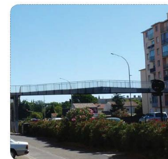
2 Passerelle piétonne sur le bd Allende
