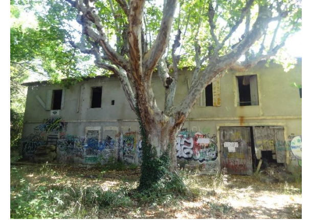
- Le bâtiment correspondant au « Grand Mas » (8) (ancienne habitation)
