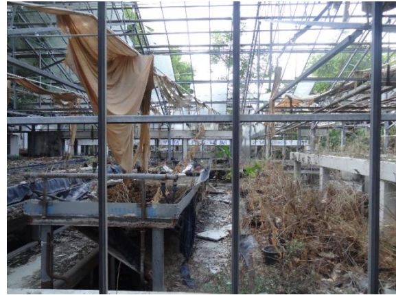
- D'ancienne serres (4) correspondant aux anciennes serres de vente avec présence de 2 citernes aériennes (nature du contenu inconnu)
